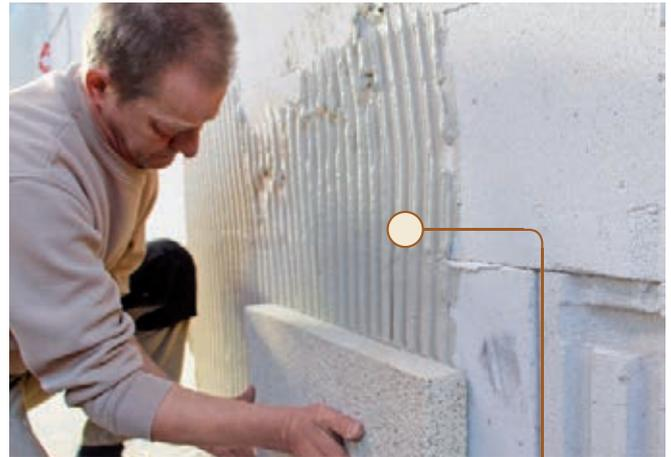
Mittels mineralischem Mörtelkleber werden die Liquid Pore® Platten einfach vollflächig auf die Wand geklebt. Die mineralische Basis ermöglicht einen diffusionsoffenen Aufbau. So kann die Fassade "atmen" und das Wohnklima wird spürbar verbessert.
