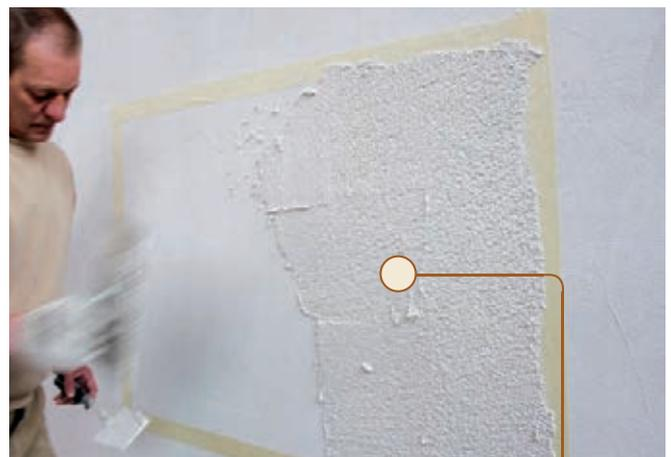
Auf eine abschließende Grundierung wird schließlich der Rauhputz aufgetragen und glattgezogen. Dank der Verwendung mineralischer Materialien gelingt es, eine "gesunde" Fassade zu schaffen, die das Wohlbefinden steigert.
