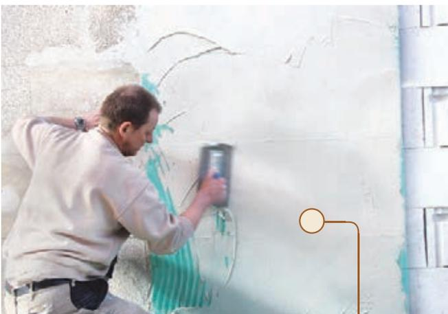
Auf die Liquid Pore® Platten wird mit einem mineralischen Mörtelkleber ein stabilisierendes Gewebe aufgeklebt. Mit einem Spachtel lässt sich die Oberfläche anschließend einfach glattziehen.
